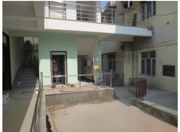
Unten: Sicht in den Innenhof zum Treppenhaus mit Lift
